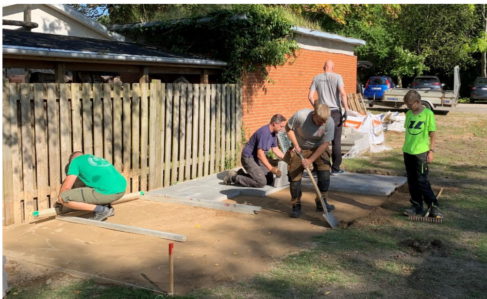
Engagerede forældre lægger flisefundamentet til det kommende skur.
